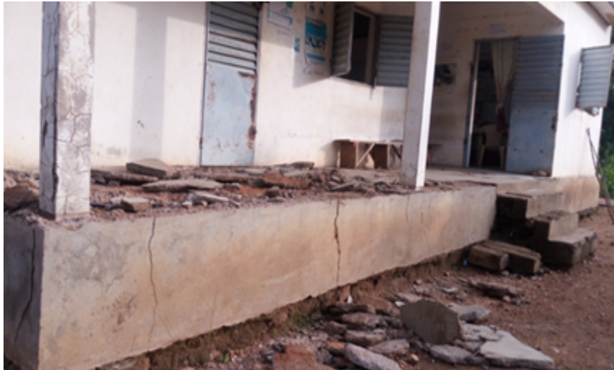
Photo du bâtiment avant le PBF
