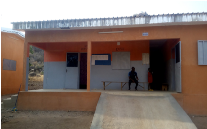
Photo du même bâtiment rénovés après le PBF
